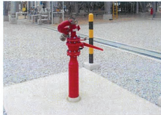
ภาพที่ 2.2-22 Fire Monitor Gun
