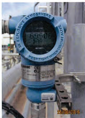
ภาพที่ 2.2-31 อุปกรณ์ตรวจวัดอุณหภูมิและความดัน
