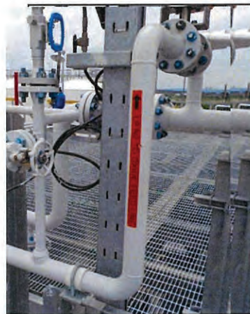
ภาพที่ 2.2-30 ท่อส่งไนโตรเจนเข้า Pad ถังเก็บกัก
