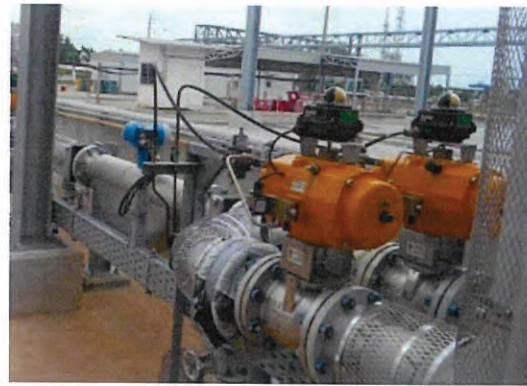
ภาพที่ 2.2-34 อุปกรณ์ตรวจวัดในเส้นท่อ และ Isolate Valve
