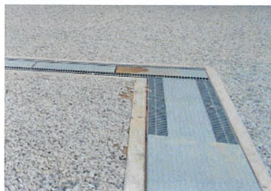
ภาพที่ 2.2-6 รางระบายน้ำในพื้นที่ก่อนลงสู่บ่อหนองน้ำ
