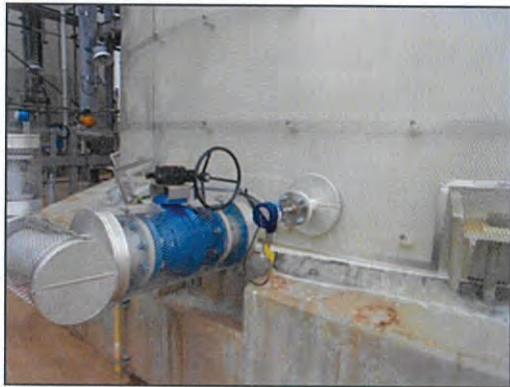
ภาพที่ 2.2-35 อุปกรณ์ตรวจวัดอุณหภูมิของถังผลิตภัณฑ์
