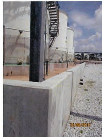
ภาพที่ 2.2-28 เชื้อนก้นบริเวณถังสารเคมีและ ถังผลิตภัณฑ์
