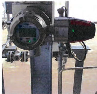
ภาพที่ 2.2-32 Flow Meter ของถังปฏิกิริยา
